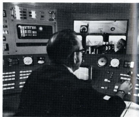
Oscar IV's instruktørplads lige bag eleven, adskilt fra denne af en glasrude, som kun indtruktøren kan se igennem. Instruktøren vælger ruteprogrammer på trykknapper. Med kontrolinstrumenter kan han følge elevens præstationer – eller som i dette billede: lokoføreren på genopfriskningskursus.
